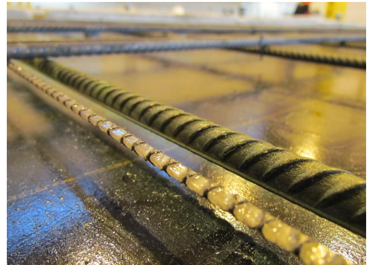
Fot. 8 Widok czujników EpsilonSensor w obszarze dolnego zbrojenia płyty [1].
